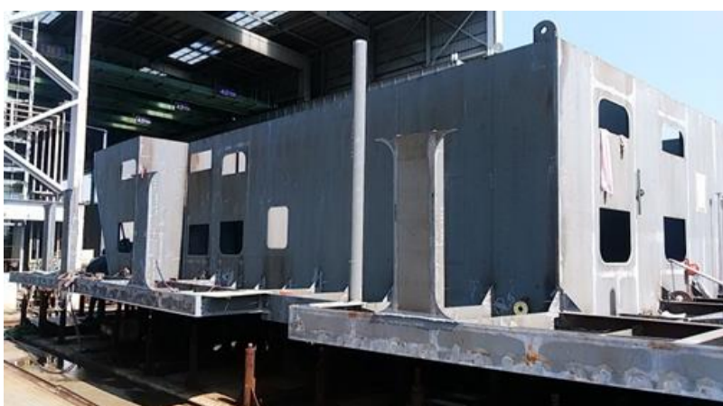
船橋ブロック組立
