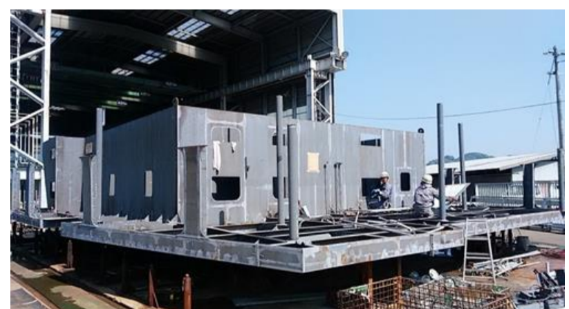
船橋ブロック組立
