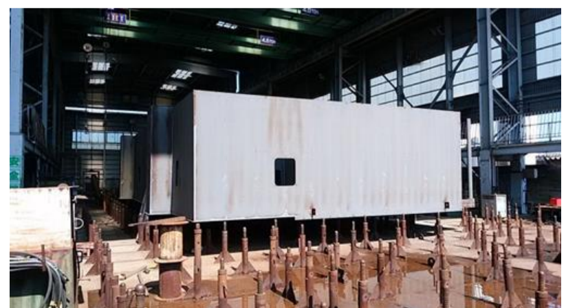
船橋ブロック組立
